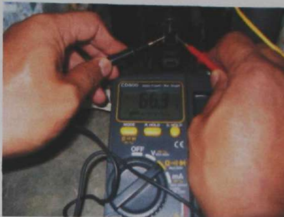
Rajah 3.11 : Ujian Menentukan Terminal ( Terminal Test ) Pada Motor Pemampat Sedang Dijalankan
