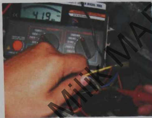
Rajah 3.15 : Ujian Penebatan ( Insulation Test ) Pada Motor Kipas Sedang Dijalankan
