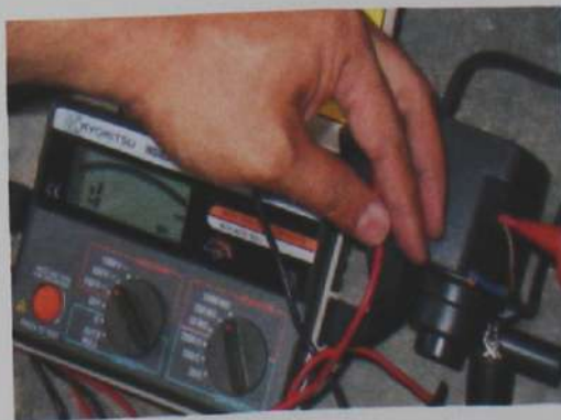
Rajah 3.16 : Ujian Penebatan ( Insulation Test ) Pada Motor Pam Air Sedang Dijalankan
